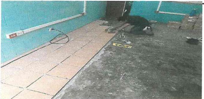
Foto 6: Sustitución de piso cerámico en torta de cemento.
