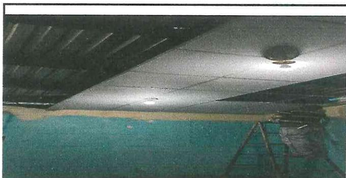
Foto 4: Instalación de cielo falso.
