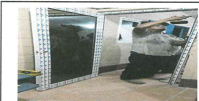
Foto 3: Sustitución de Puerta metálica por puerta de PVC
